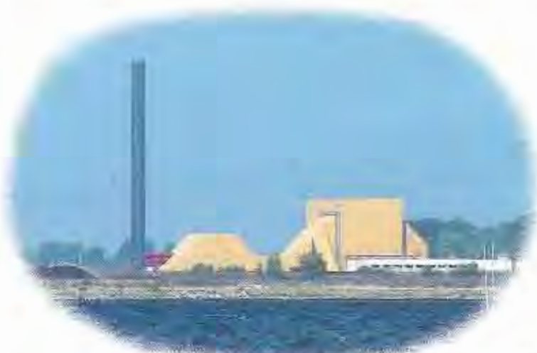
Centrale di Incenerimento Energia-Rifiuti (Vølund Ecology Systems A/S - Denmark)
